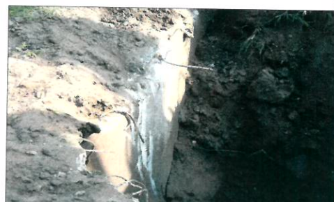
Fouille n°2 coffrage en béton entourant l'ancienne cuve
