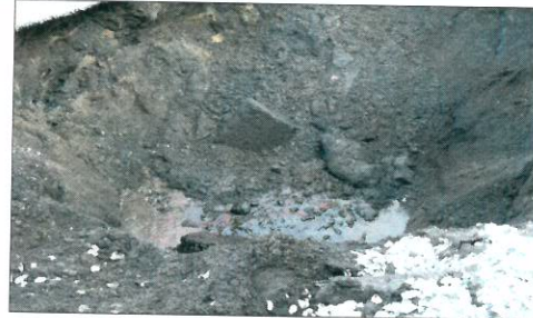
Fouille n°1 : sables au contact de la nappe
